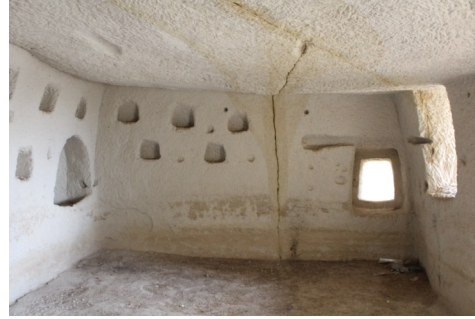
Şekil 42. 2G Yan Mekân 1, Güneybatı
