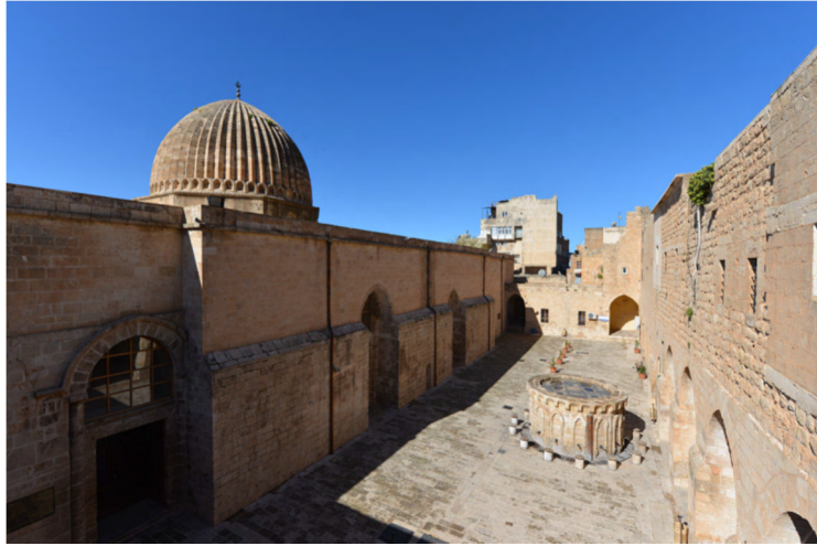
Resim 5. Mardin Ulu Cami yivli kubbe, harim duvarı, avlu ve revaklı bölüm genel görünüm (Çağlayan, 2017a)
