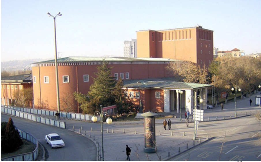
Fotoğraf 2. Bonatz'ın dönüştürdüğü Ankara Opera Binası 28
