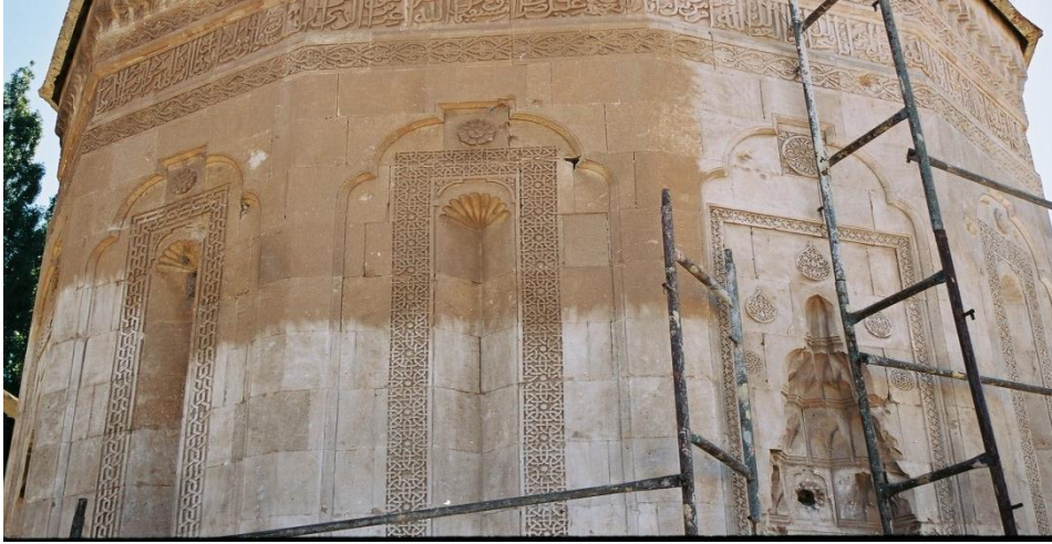
Fotoğraf 8a: Bezemeli Yüzeylerin Zımparalanması ve Patinanın Temizlenmesi
