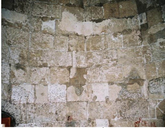
Fotoğraf 12a, b: İç Kısımda Taşçı Aletlerin Kullanımı Sonucu Oluşan Tahribat
