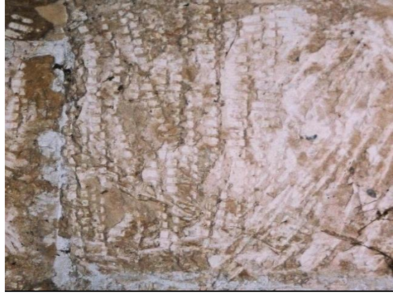
Fotoğraf 12a, b: İç Kısımda Taşçı Aletlerin Kullanımı Sonucu Oluşan Tahribat
