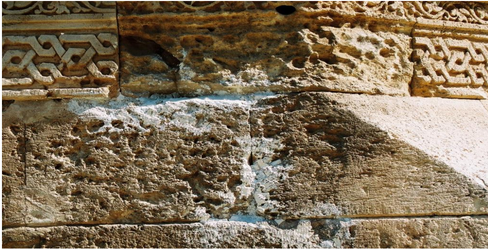
Fotoğraf 9b: Farklı Malzemenin Gelişigüzel Kullanımı
