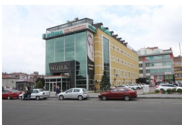
Fotoğraf 1. Dış cephe (Demir, 2018)
