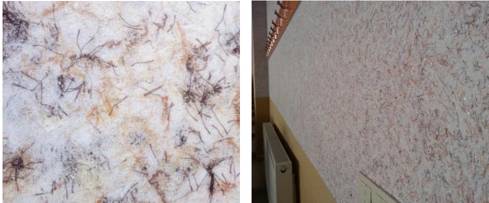
Resim 2. İyileştirme aşamasında yapılan canlı sıva detayı
